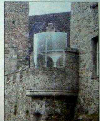
Diese neu installierte Glasscheibe sorgt für Aufregung. FOTO: ZVG
